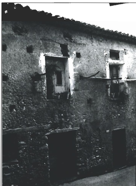
Vecchie costruzioni (ora demolite) attigue al palazzo Torcia
